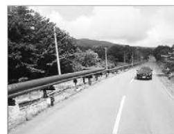
図5: 生産基地-発電基地のパイプ
