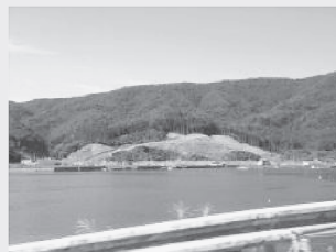
高台移転の工事の様子
